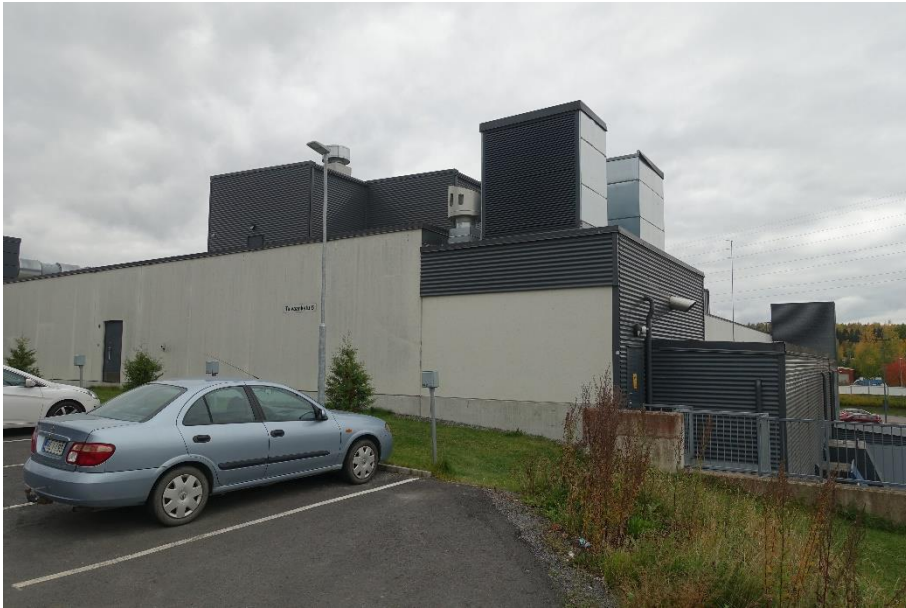
Kuva 5.2 Lielahden Prisman varastotilojen päällä olevia melulähteitä
